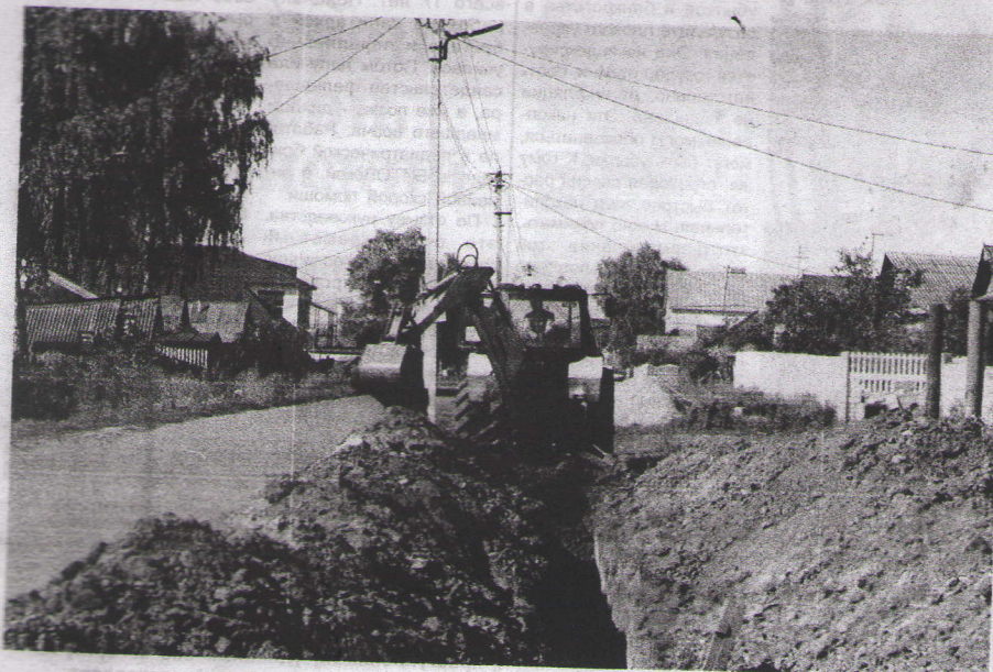
СКОРО ПРОЛОЖАТ И ТРУБЫ. Фото Ильшата Гайсарова.
